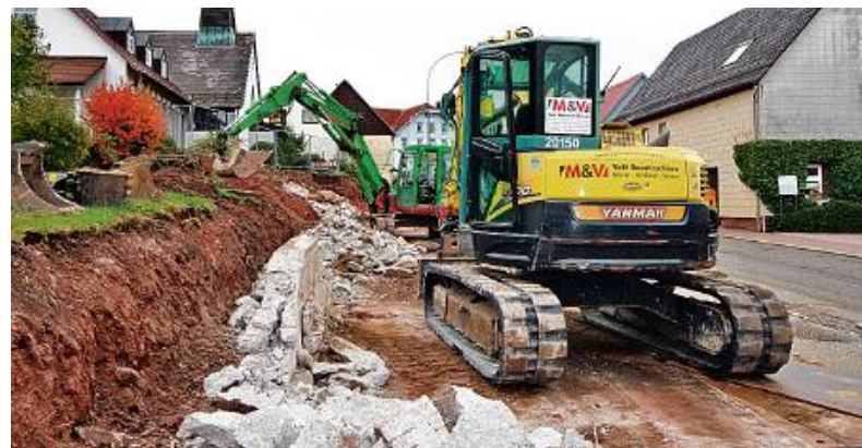
Die Bushaltestelle Schubertstraße in Salmbach ist schon verschwunden. Wenn alles glatt läuft, halten dort im Dezember wieder Busse. FOTO: DAST-KUNADT
